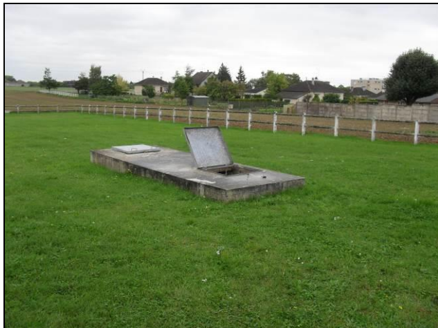
Photographie 1 : Tête du captage de la Rigorne
